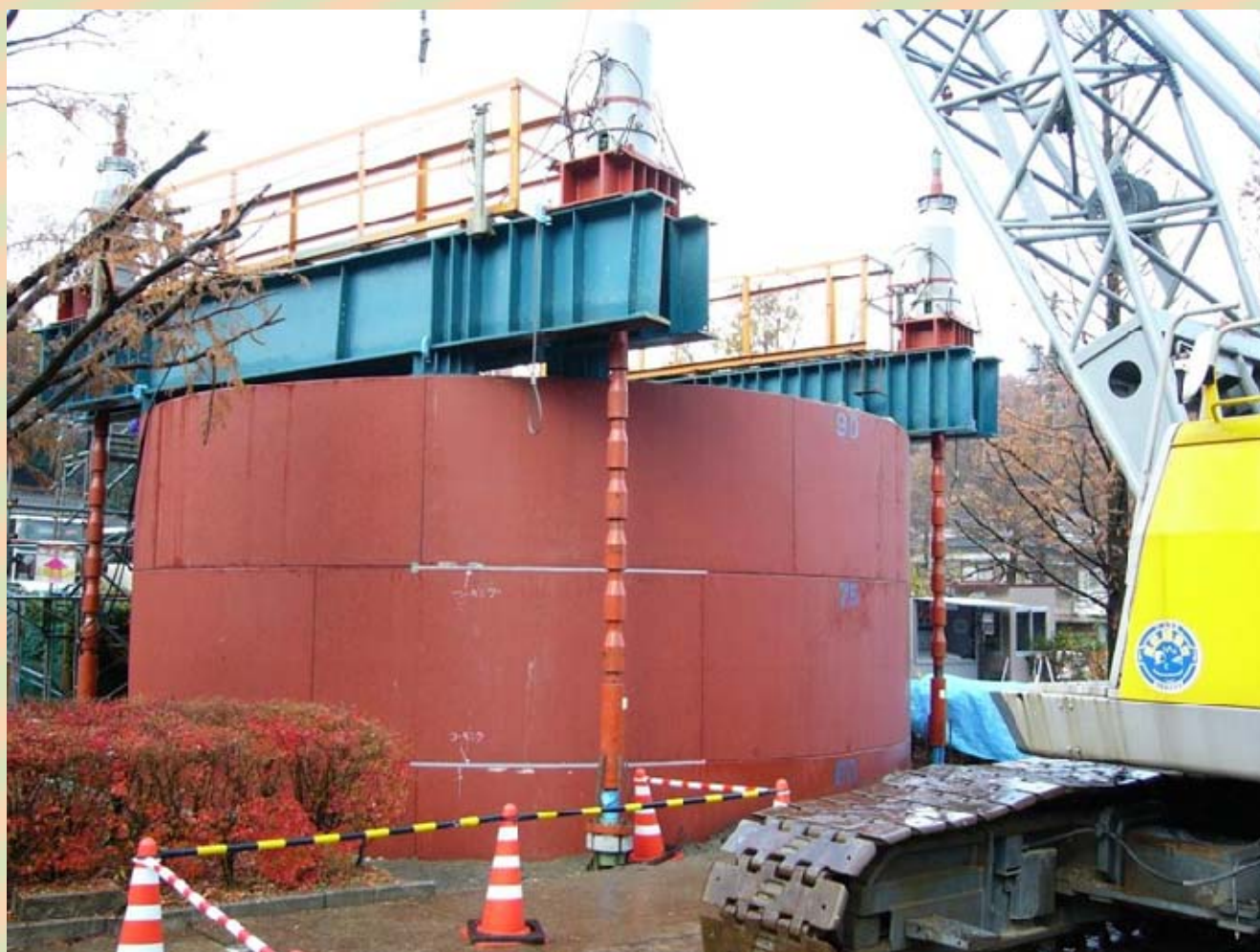
NSshaft®の圧入状況
